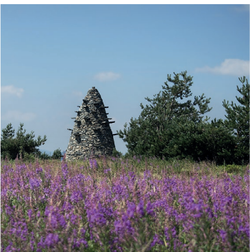
3 LA CHAUMASSE – SAGNES-ET-GOUDOULET LA TOUR À EAU - THE WATER TOWER GILLES CLÉMENT
